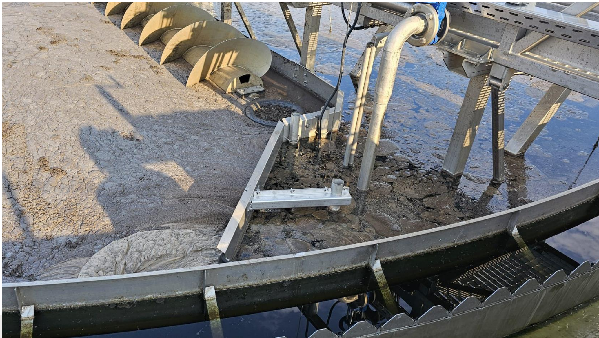
Osadnik wtórny Obiekt 5B ze zgarniaczem flotatu
