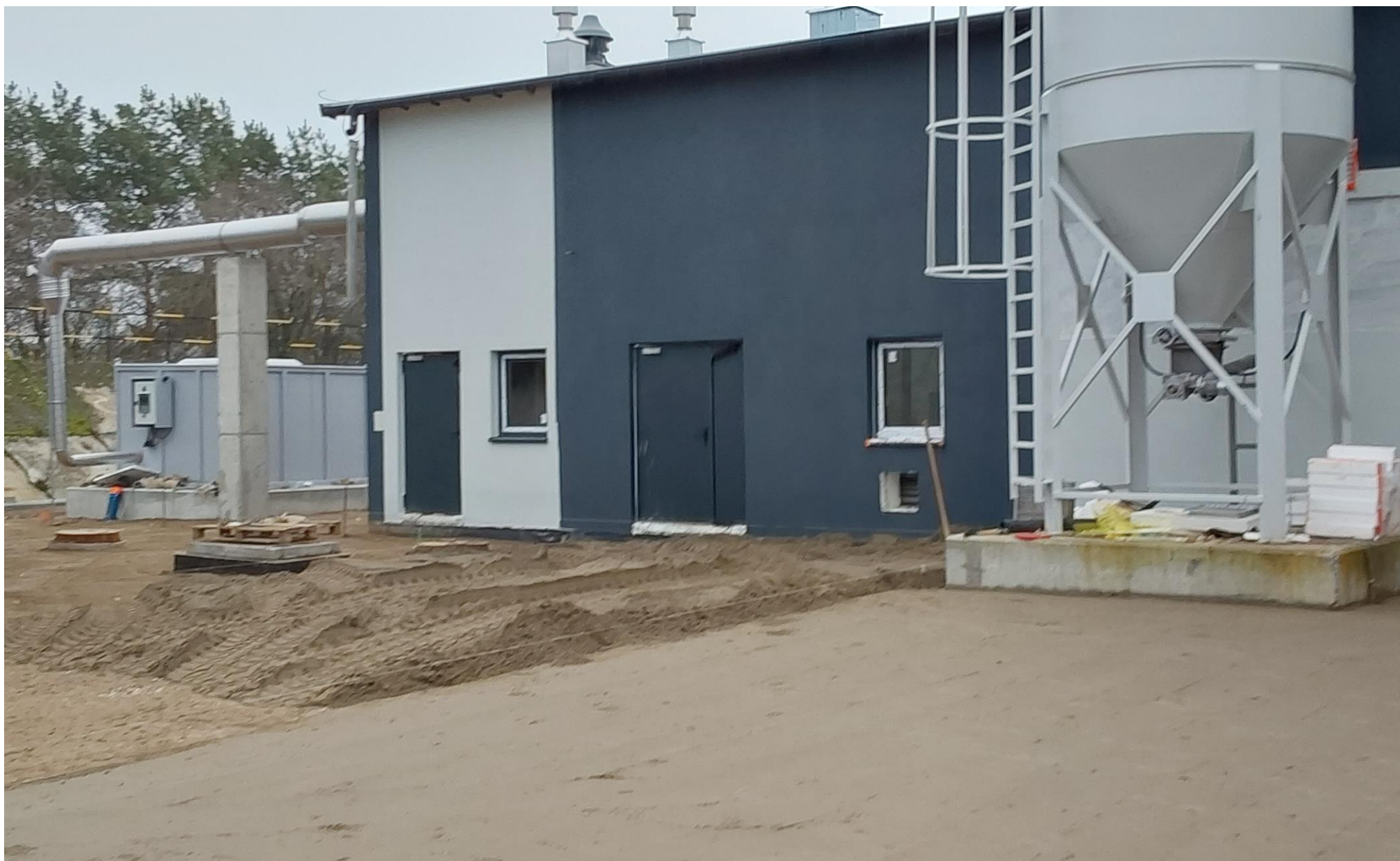
Elewacja na budynku odwadniania osadu.
