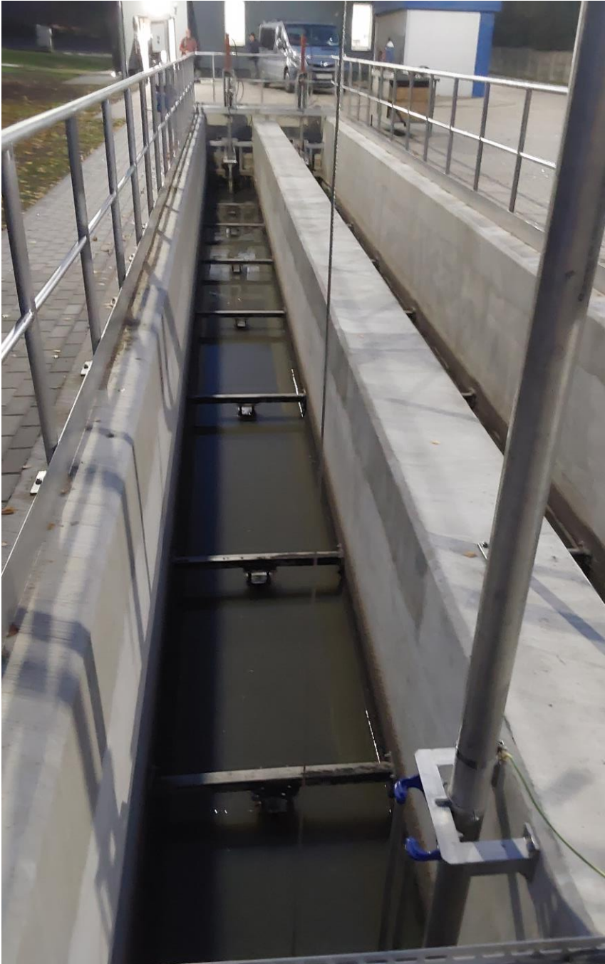
Piaskownik z płuczką piasku po rozruchu technicznym
