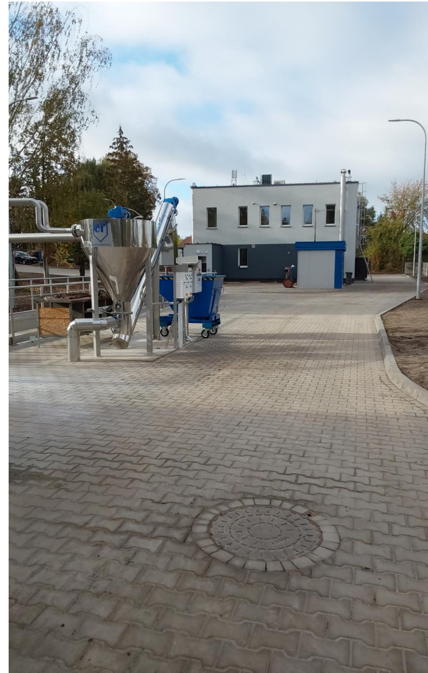
Widok na płuczkę piasku i budynek przepompowni.
