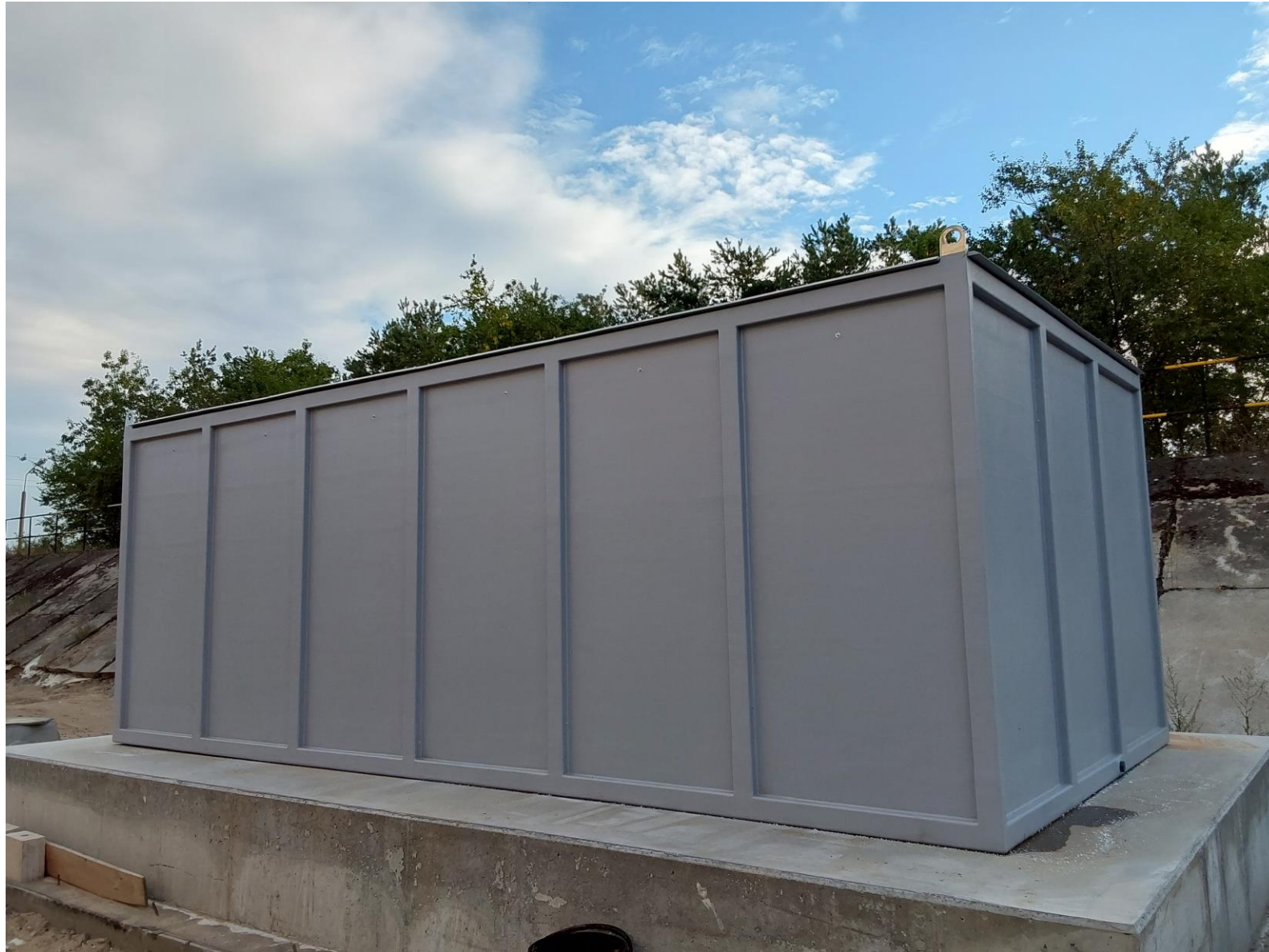
Budynek biofiltru przy budynku odwadniania osadu
