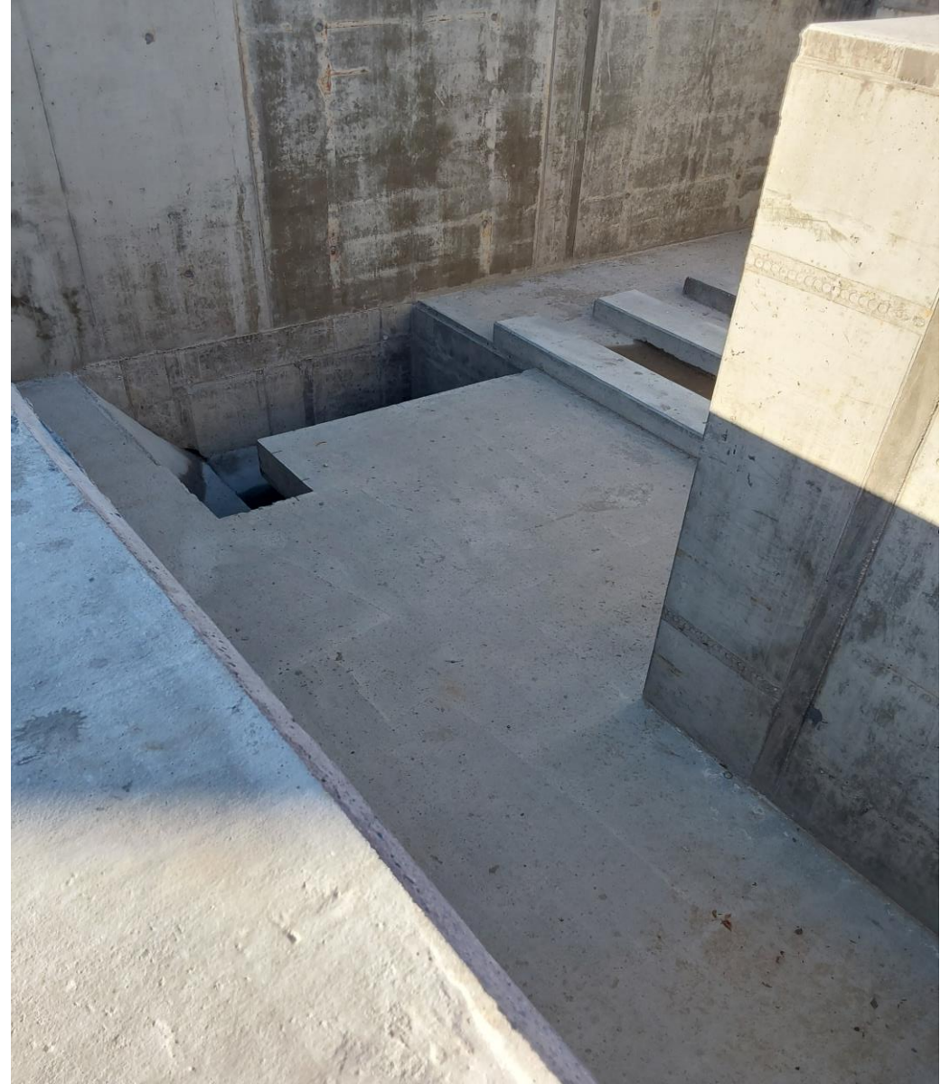
Stacja do podczyszczania osadu z czyszczenia studzienek
