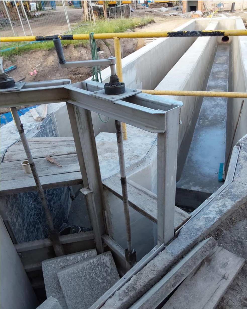
Remont piaskowników oraz kraty wraz z prasopłuczką skratek w budynku krat na Przepompowni
