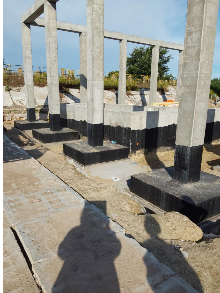
Stacja do podczyszczania osadu z czyszczenia studzienek
