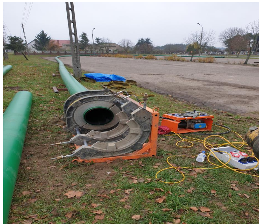
Układanie rurociągów tłocznych
