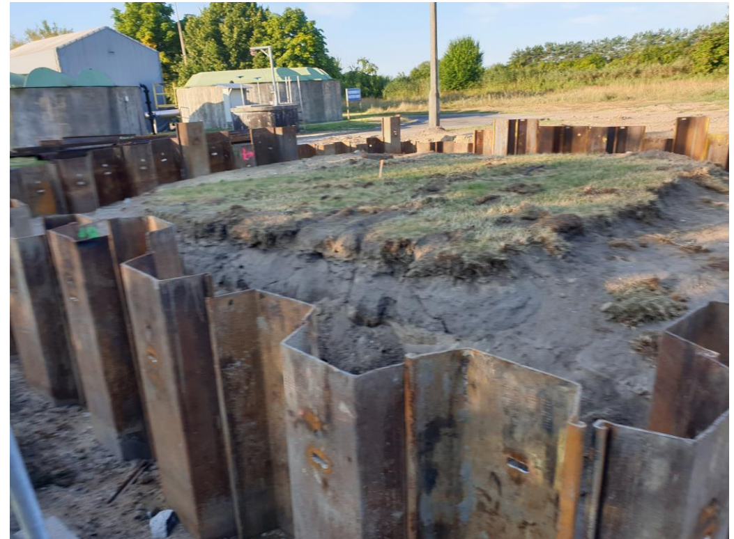
Osadnik wtórny- przygotowanie odwodnienia terenu
