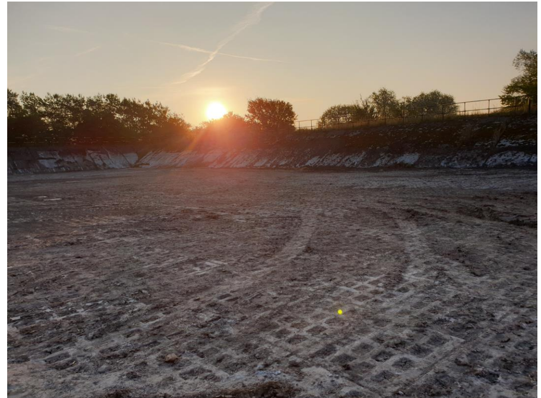
Laguny – utylizacja i przygotowanie terenu do gospodarki osadowej
