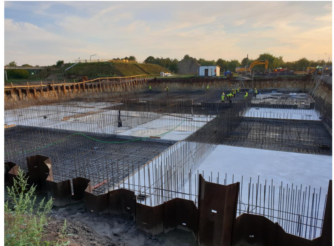
Reaktory biologiczne- prace związane z betonowaniem dna
