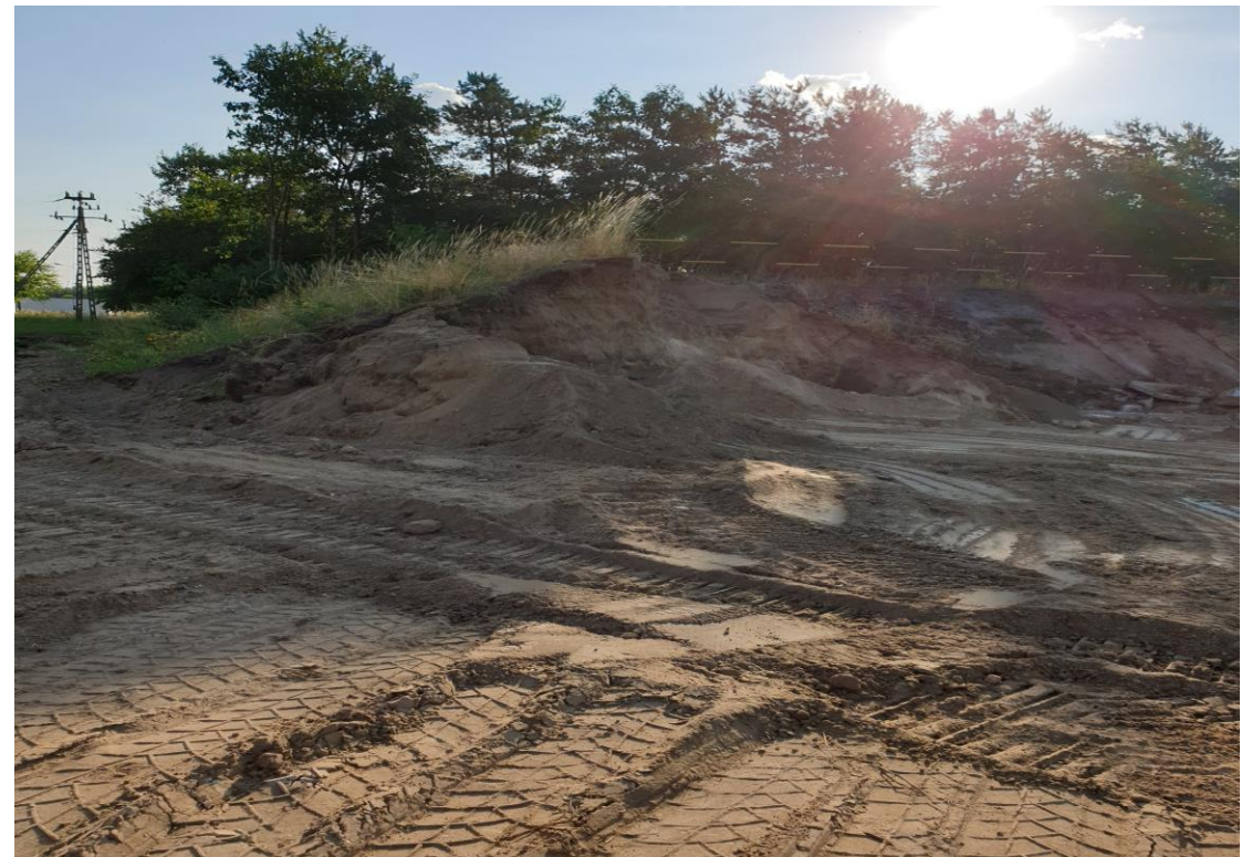
Przygotowywanie terenu starych lagun pod nową gospodarzkę osadową
