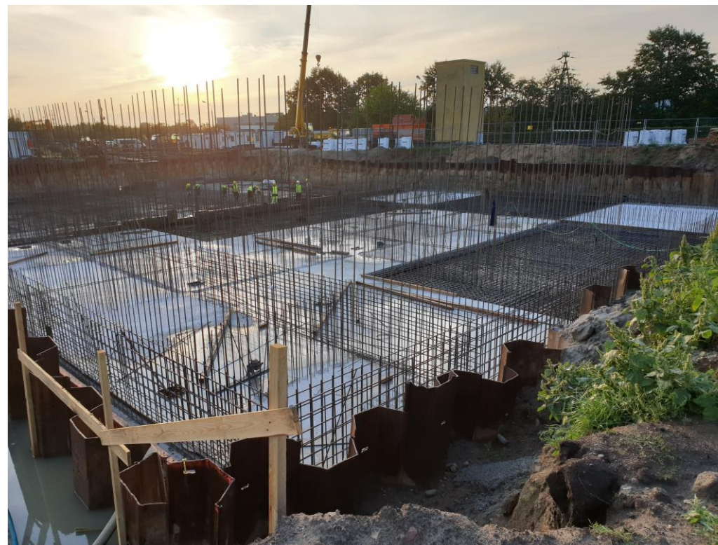
Układanie zbrojenia w dwóch komorach reakcji
