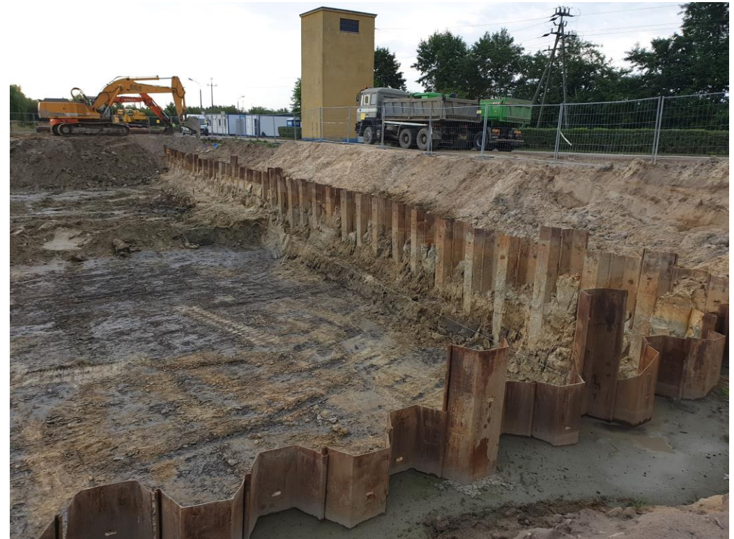
Przygotowanie odwodnienia po budowę reaktorów
