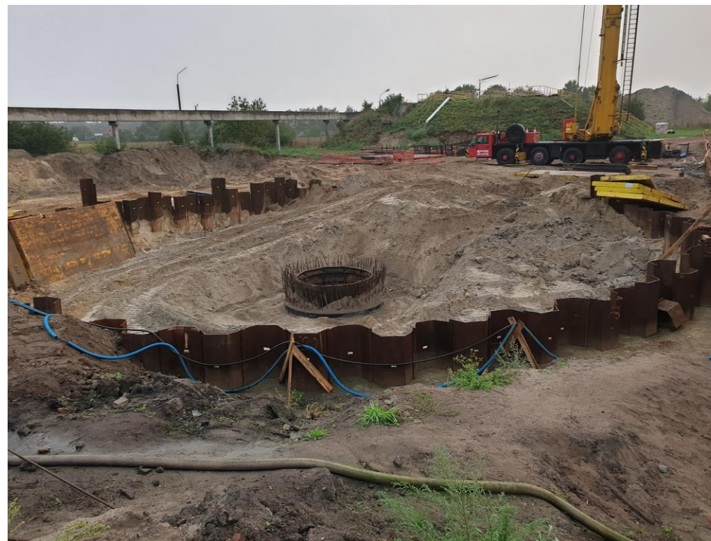
Prace przy osadniku wtórnym
