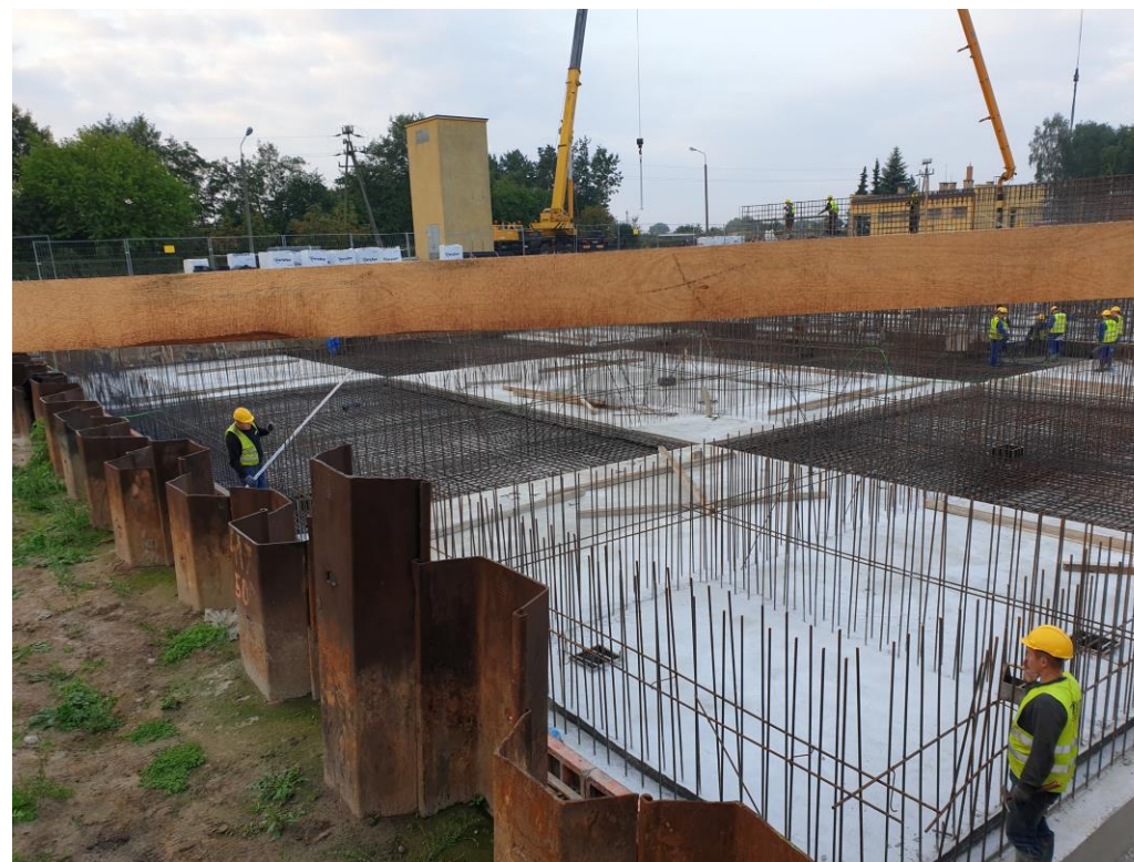
Reaktory prace budowlane
