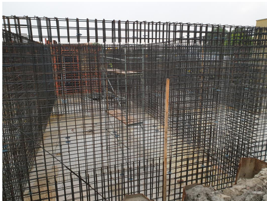
Prace przy osadniku wtórnym
